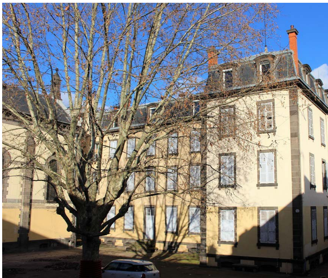
Ancien groupe scolaire Monanges © Association L'Arche
